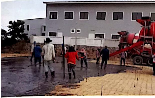
งานพื้นคอนกรีตวงรี (ทำสนามฟุตบอล)
