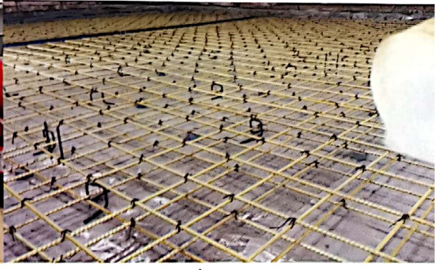
งานพื้นเฟลตสแลป (FLAT SLAB)
